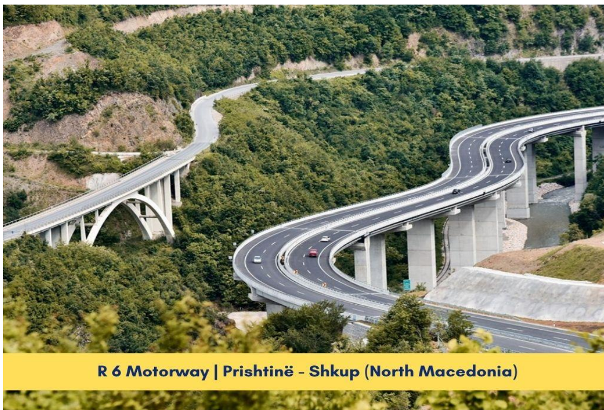
Foto | Autostrada R6 “Arbër Xhaferi “ dhe lidhja me Korridoret Paneuropiane 8 dhe 10
